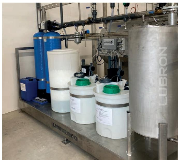
Die erwähnten Druckschwankungen bei der Wasserversorgung können besonders bei der Reinigung der Produktionshallen auftreten, wo große Mengen Wasser mit hohem Druck abgezogen werden. Das Wasch-/Reinigungswasser wird durch eine große Duplexenthärtung aufbereitet und mit 4° dH auch als Trinkwasser und für den Sanitärbereich verwendet.
